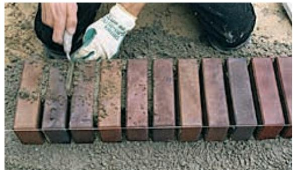
4. Verfugen der Rollschicht
