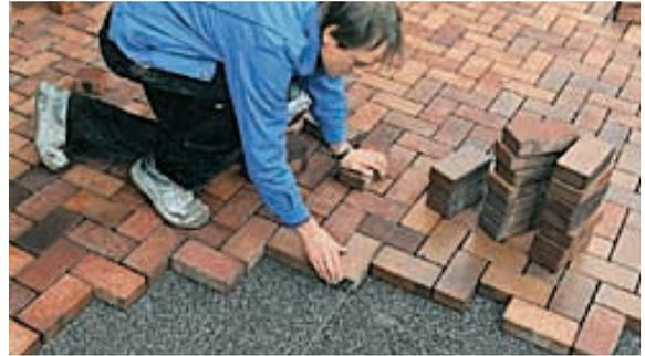
6. Verlegung des Ellenbogen-Verbands entlang der Schnüre mit Fugen von mindestens 3 - 5 mm Breite. Bereitstellung der Klinker
