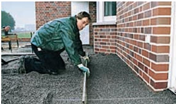
5. Abziehen der Bettung zwischen zwei geneigten Führungsrohren
