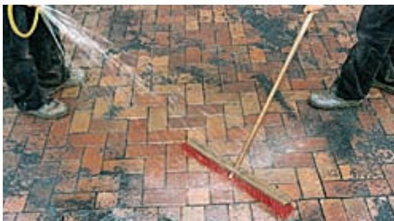
11. Einschlämmen des Brechsands mittels Wasserschlauch und Besen
