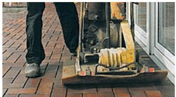
12. Abrütteln der verfugten Pflasterfläche mit Gummiplatte, und zwar vom befestigten Rand zur Mitte hin
