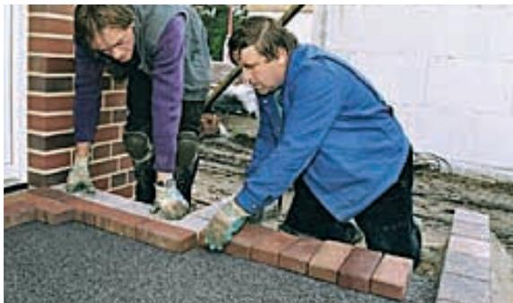
1. Verlegung der ersten Pflasterklinkerreihe, anschließend an den obersten Auftritt der geplanten Treppe
