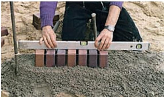
3. Setzen der Rollschicht für die Randeinfassung
