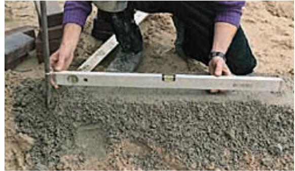
2. Ausnivellieren des Mörtelbettes unter Berücksichtigung des Gefälles und des weiteren Pflasteraufbaus
