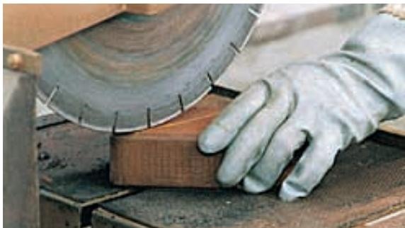
9. Zuschneiden der Passstücke mittels Trennscheibe oder Diamantsäge
